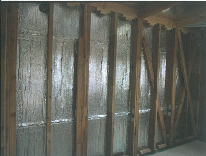
硬質ウレタンを吹付ける前の室内側、壁
