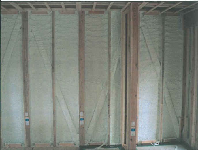
硬質ウレタンを吹付けた後の室内側、壁
