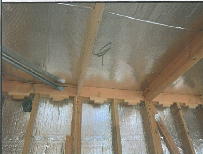
硬質ウレタンを吹付ける前の室内側、天井と壁
