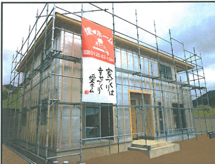
両面アルミ反射シートと通気胴縁の施工が完了した外観
