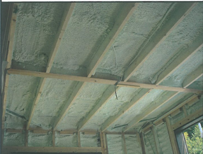
硬質ウレタンを吹付けた後の室内側、天井
