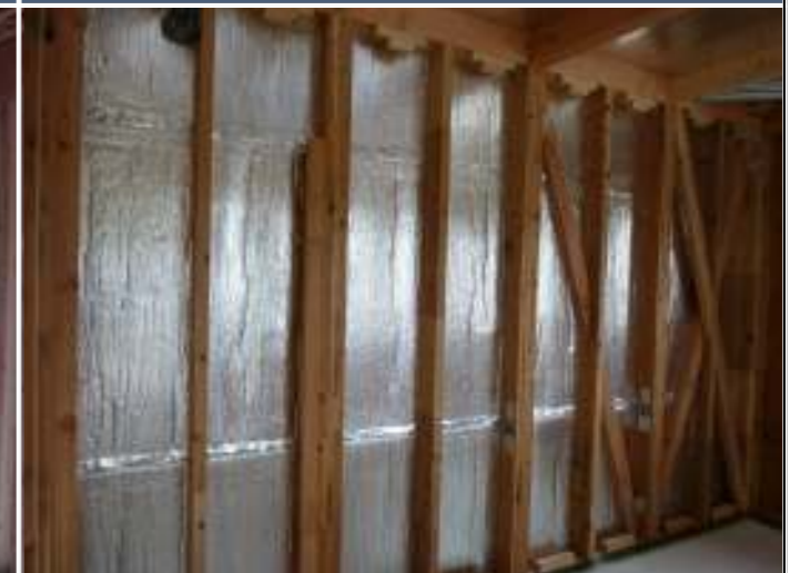
硬質ウレタンを吹付ける前の室内側、壁
