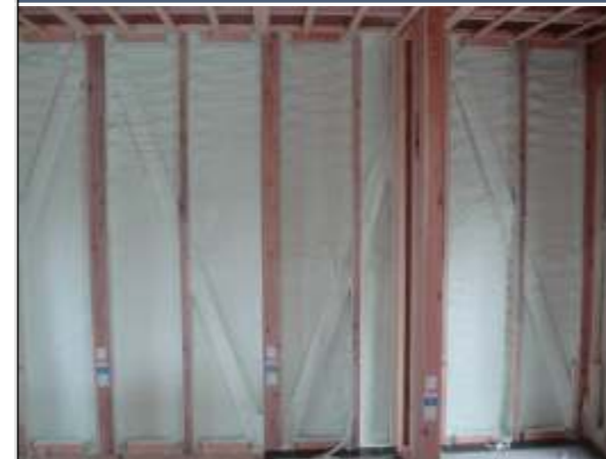
硬質ウレタンを吹付けた後の室内側、壁
