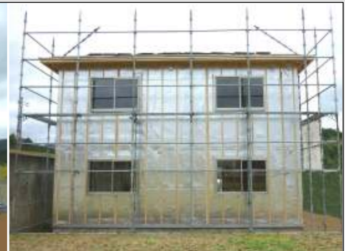
アルミ反射シートと通気胴縁の施工が完了
