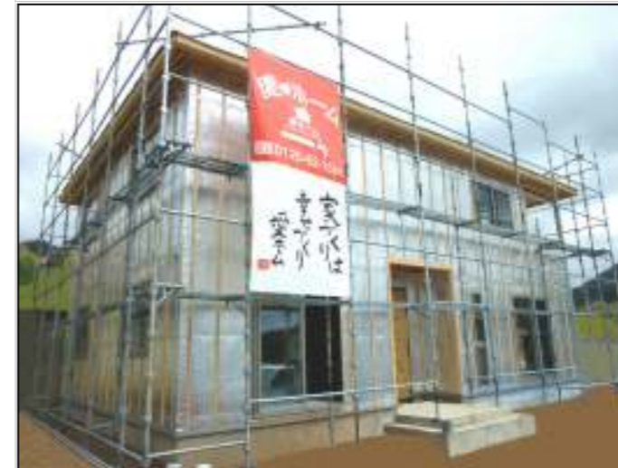
アルミ反射シートと通気胴縁の施工が完了
